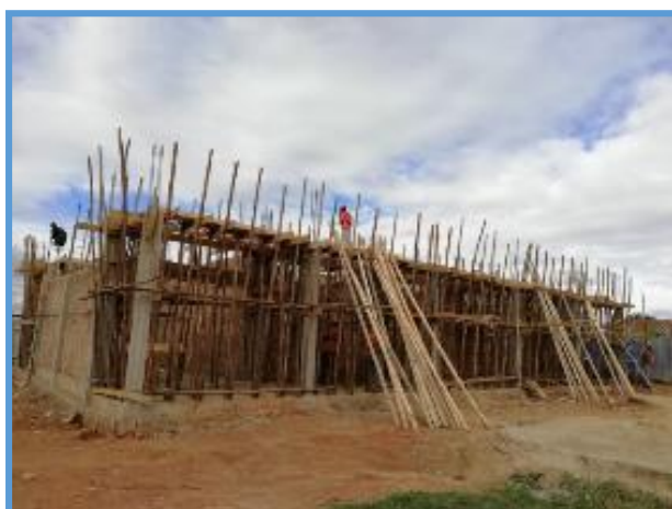
Nouvelle construction d'un Lycée à Mahatsara
