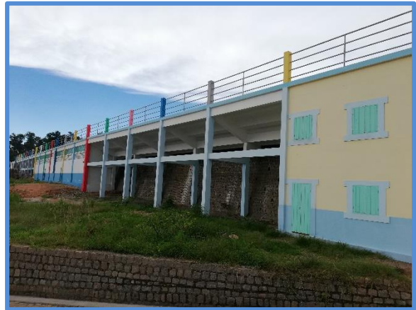
Nouveau gradin ouest du terrain de foot
