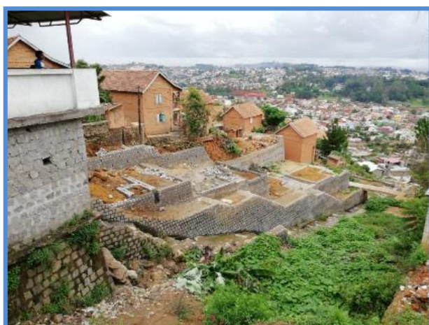
Fondation des quatre nouveaux logements sur un mur de soutènement
